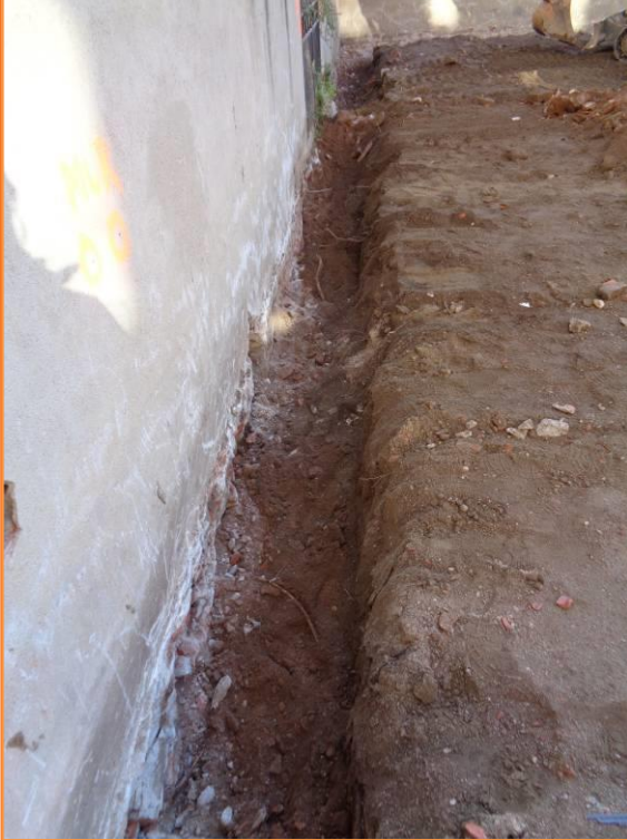
Foto 69. Vista de proximitat de la rasa per fer el mur guia al límit nord del solar.
