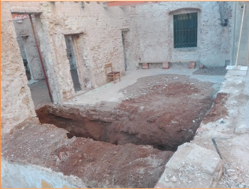
Foto 33. Vista de la rasa 2.
