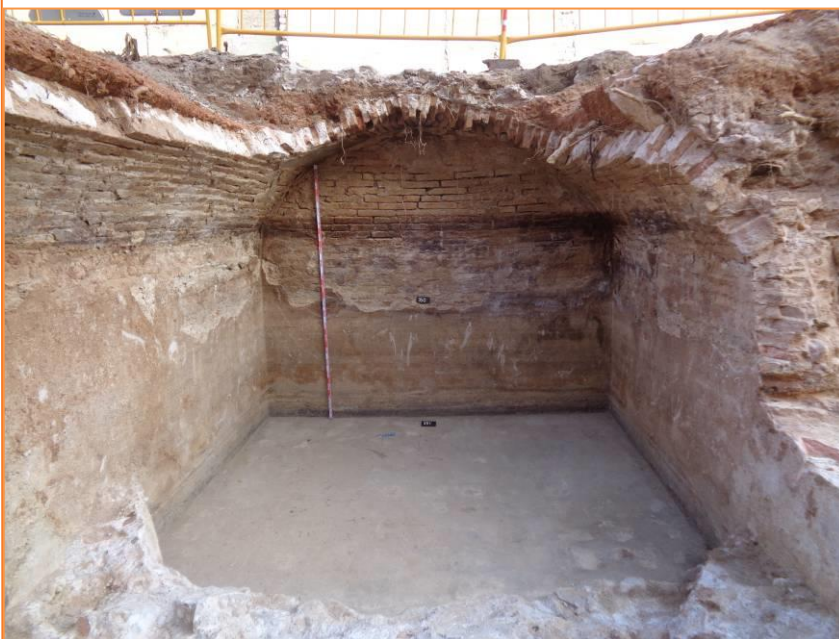
Foto 60. Vista de proximitat del dipòsit UE 350.
