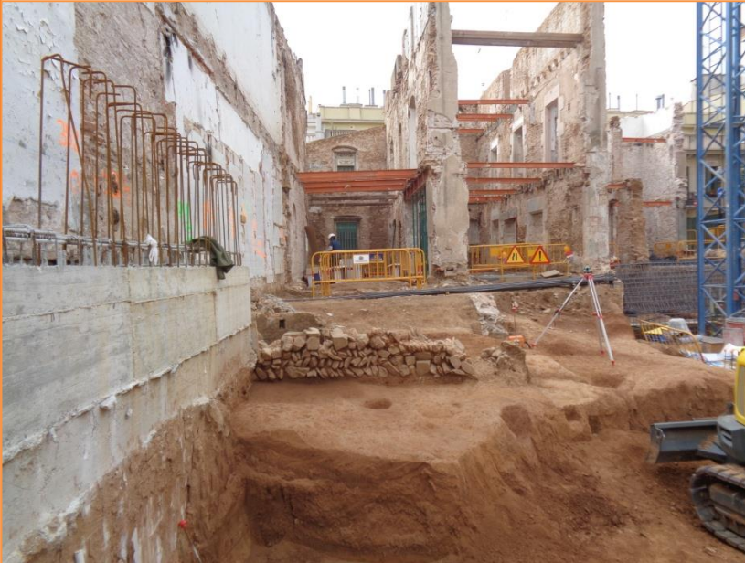
Foto 49. Vista final del mur UE 450 des del nord.
