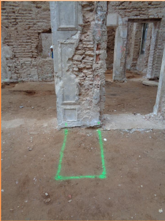
Foto 31. Vista inicial del sondeig 6.
