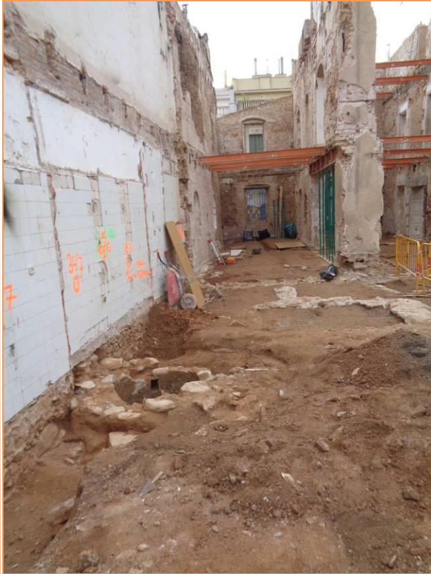
Foto 77. Vista de situació del pou UE 358 respecte a la masia.
