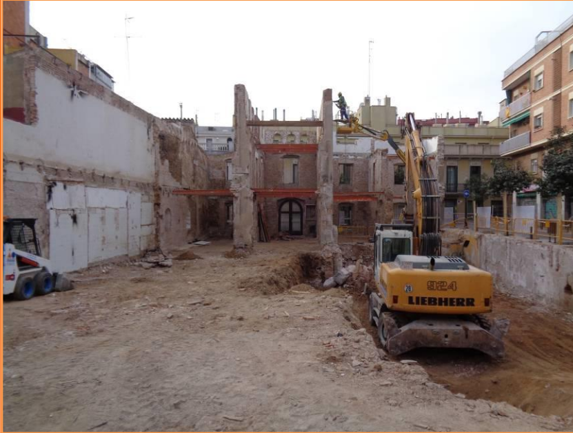
Foto 1. Vista general de l'edifici i solar on es fa la intervenció.
