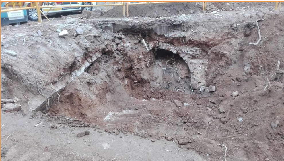
Foto 58. Vista inicial del dipòsit UE 350.
