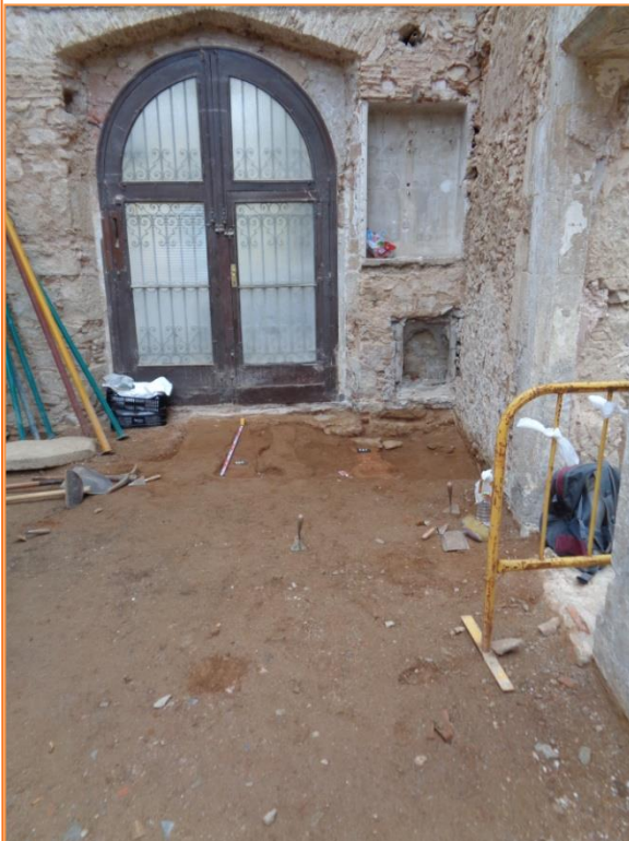
Foto 20. Vista inicial del sondeig 3.
